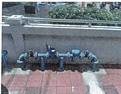
(ฐ) การติดตั้งมิเตอร์วัดปริมาณน้ำใช้ด้านหน้าโครงการ
