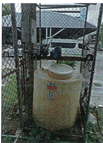
(ช) ระบบฆ่าเชื้อโรคด้วยคลอรีนระบบบำบัดน้ำเสียและระบบระบายน้ำโครงการ
