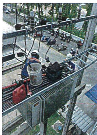
(ฅ) การตรวจสอบระบบไฟฟ้าภายในโรงพยาบาล และ บำรุงรักษาหม้อแปลงไฟฟ้า
